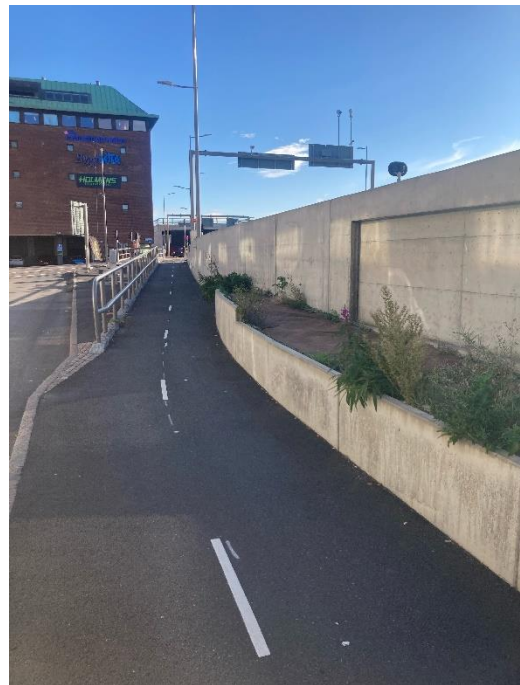
Figure 1 Betongkonstruktion som reducerar vibrationer från Norra Sjöfarten (västerut /österut)
