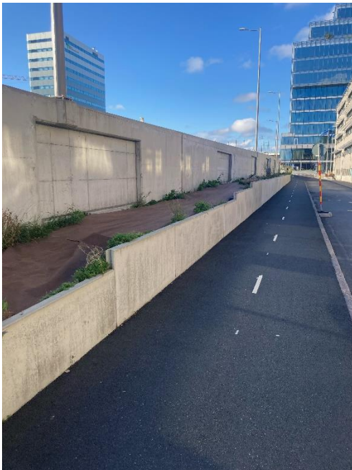
Figure 1 Betongkonstruktion som reducerar vibrationer från Norra Sjöfarten (västerut /österut)
